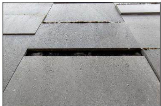
Afbeelding 3.2. Ruimte tussen stenen en muur.
