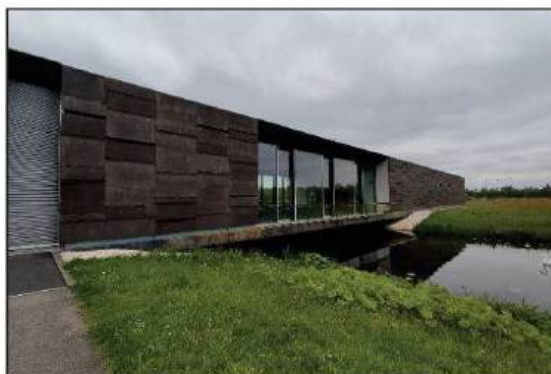
Afbeelding 2.3. Achterzijde van het gebouw.
