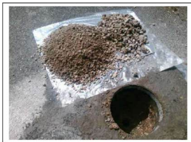
Foto 2. Opgegraven en gezeefd materiaal inspectiegat 07A
