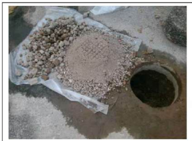
Foto 3. Opgegraven en gezeefd materiaal inspectiegat 08A
