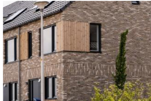
Gevels zijn primair in baksteen uitgevoerd, met accenten in hout als mogelijkheid.
