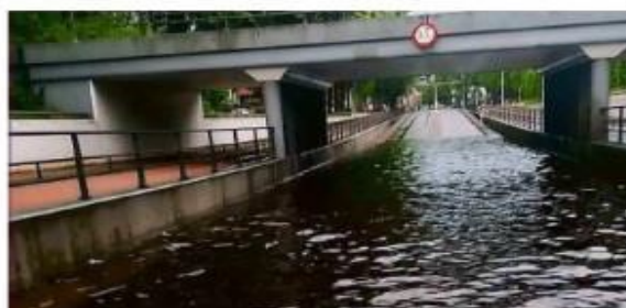
Tunnel Koornbeursweg, Heerenveen. FOTO JOLANDA VESSER
