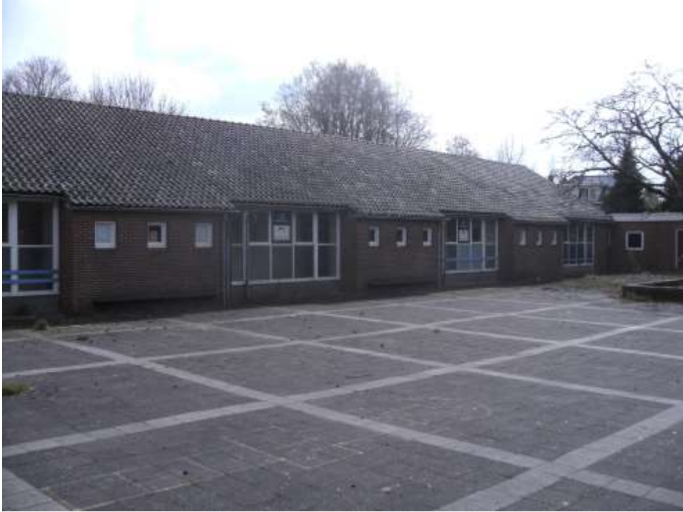
Noordgevel te slopen bouwdeel 1953 / 1963. (met slooplijn)
