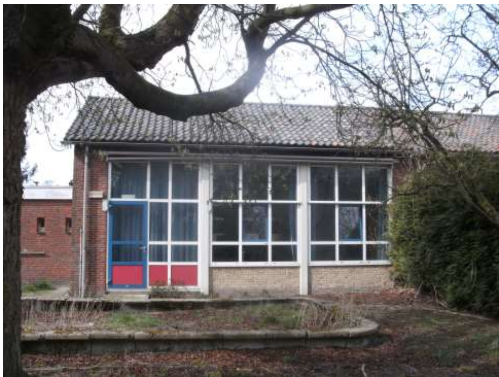
Zuidgevel te slopen bouwdeel 1963.
