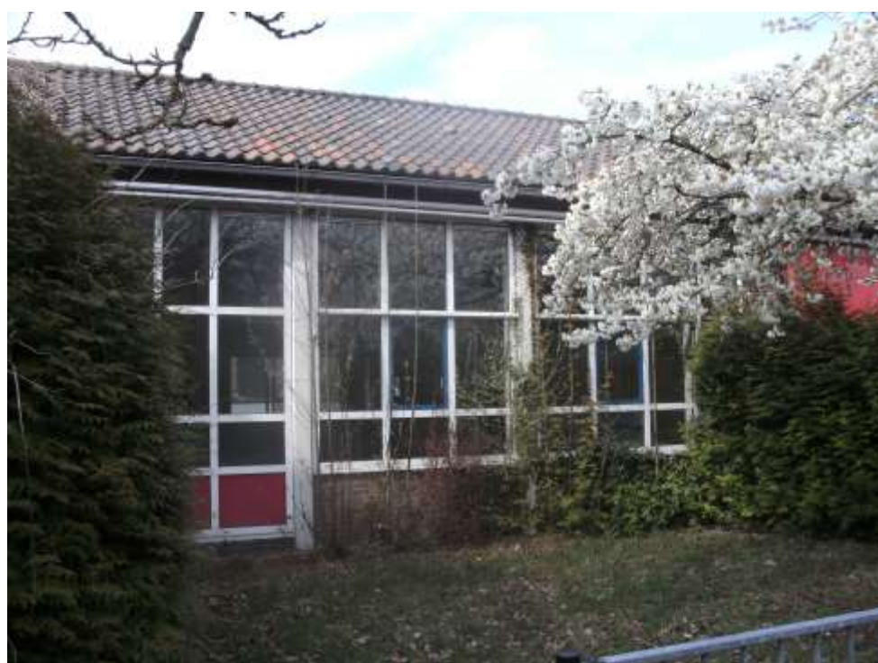
Zuidgevel te slopen bouwdeel 1953. (met slooplijn)
