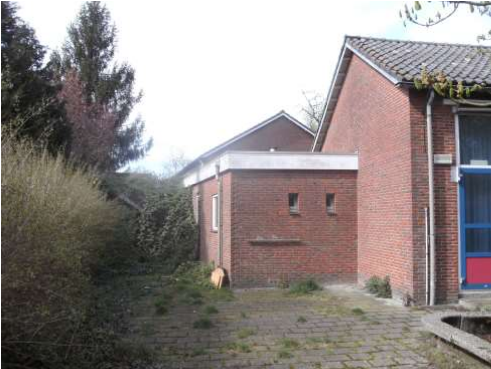
Westgevel te slopen bouwdeel 1963.
