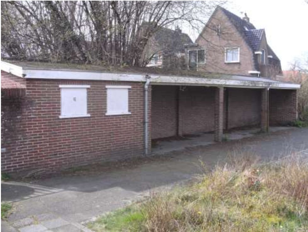
Te slopen overdekte fietsenstalling met bergruimte 1953.
